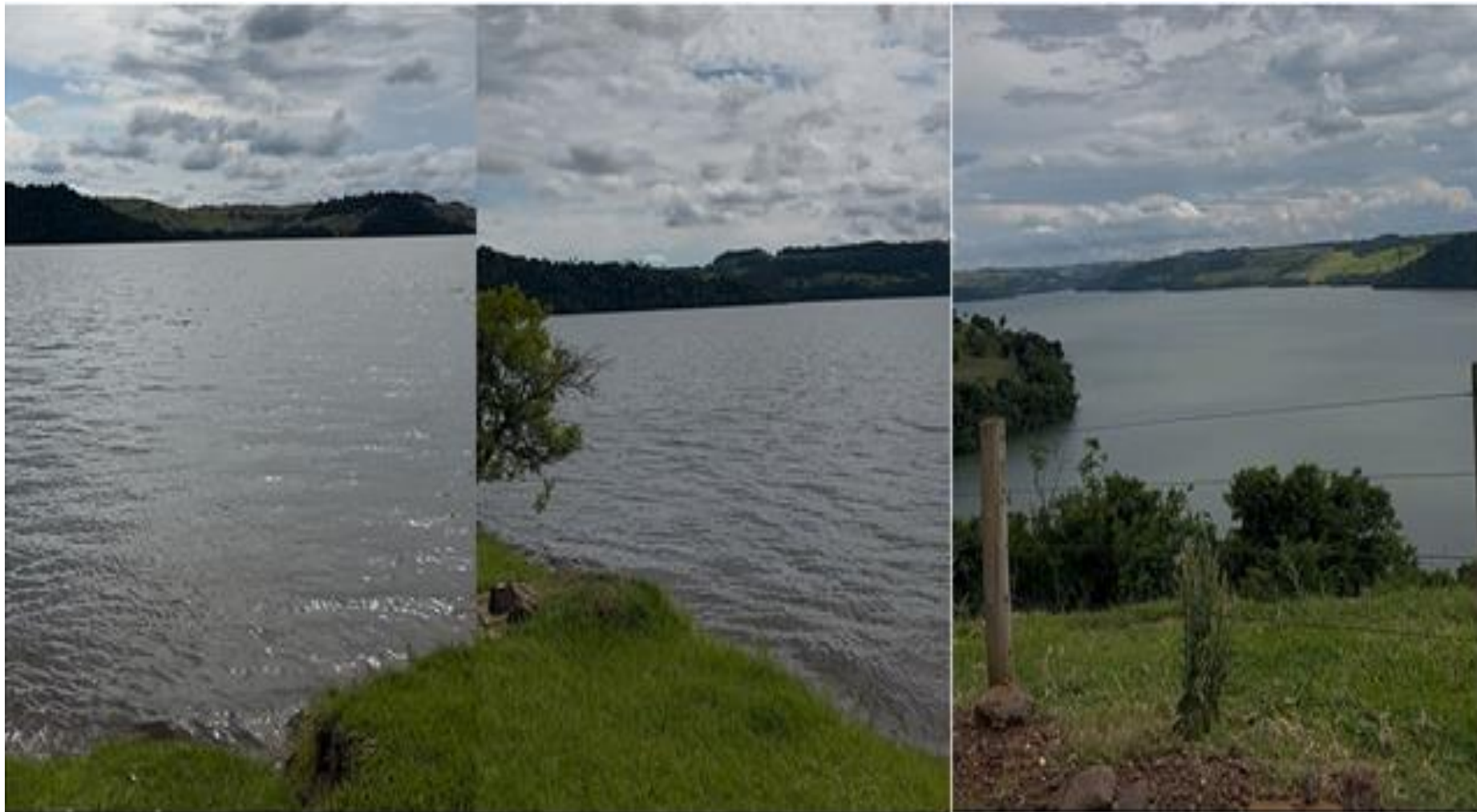
Figura 15 – Alagado da Usina Hidrelétrica de Salto Santiago em Porto Barreiro
