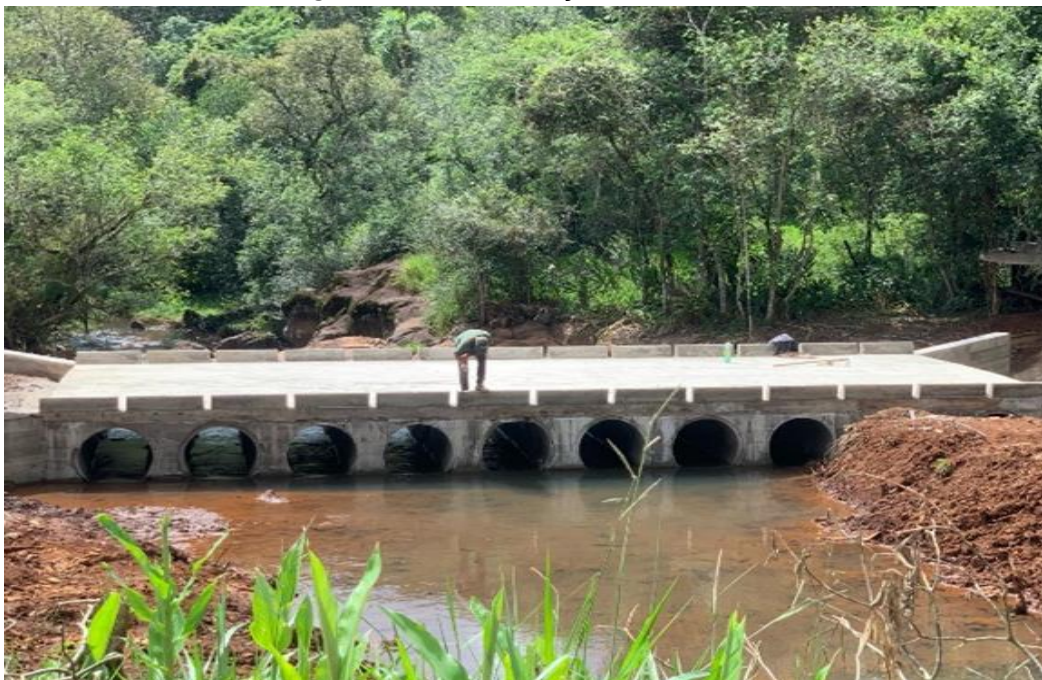
Figura 46 - Construção de Pontes
