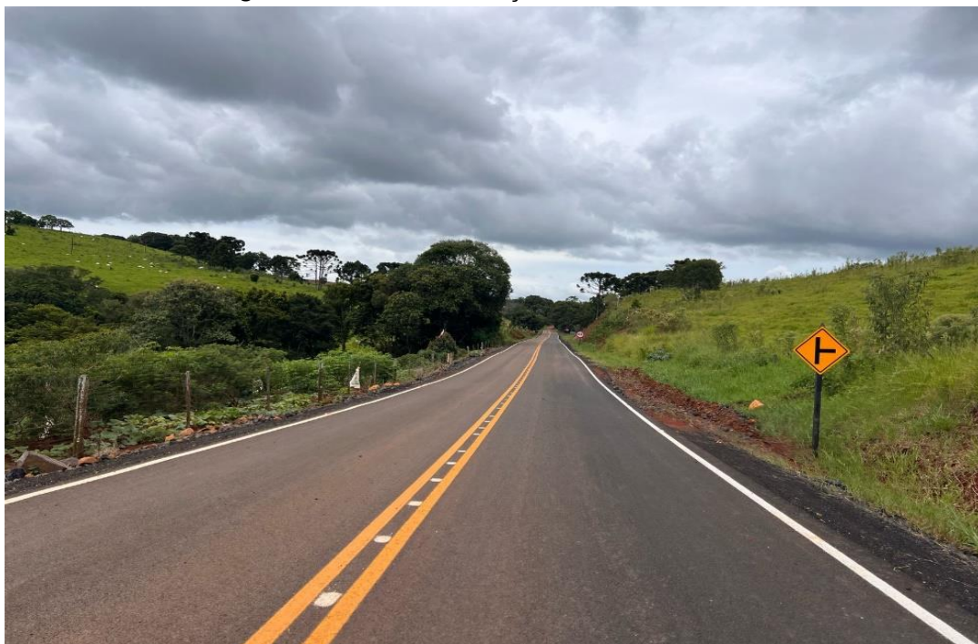
Figura 44 – Pavimentação Asfáltica PR 158
